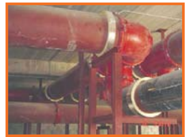
沙烏地阿拉伯Riyadah的Rashid購物廣場，24" 冷水管路
