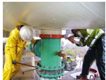
美國·廢水處理管路
